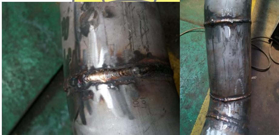
Gambar 3. Pengelasan pada sambungan pipa
