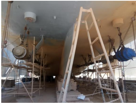
Gambar 3. Shaft Plopper Cpp Banjar Masin Sudah Terpasang.
