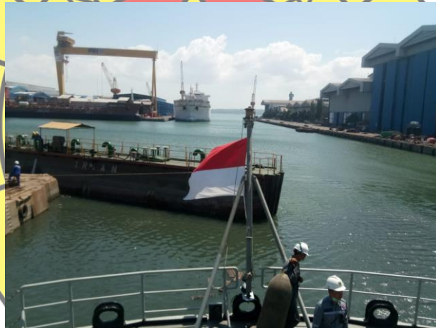
Gambar 1. Proses membuka pintu dock
