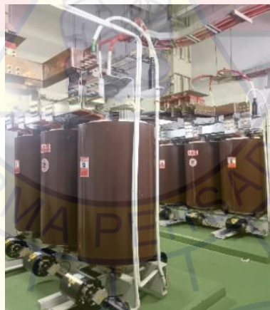
Gambar 2. 1 Trafo Cast Resin
