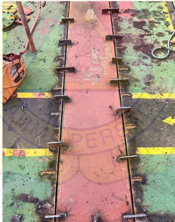
Gambar 9. Fit Up Check pada Replating Main Deck Sumber : Dokumentasi milik pribadi
