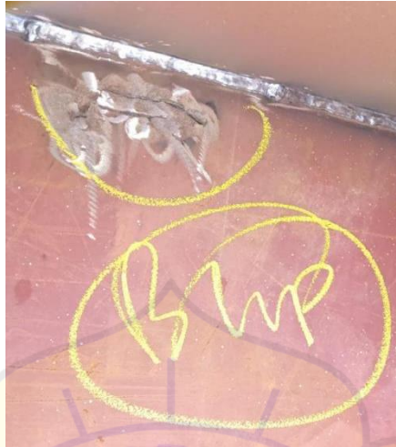
Gambar 18. Build up pada material long bulkhead Sumber : Dokumentasi milik pribadi
