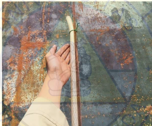
Gambar 31. Air Test Void Tank menggunakan media Selang Sumber : Dokumentasi Milik Pribadi
