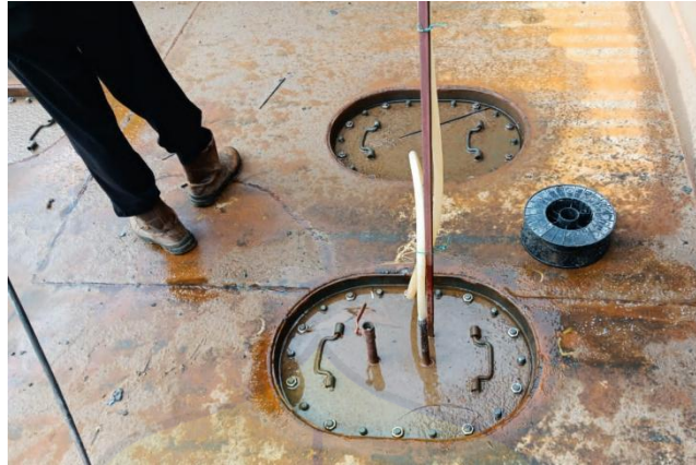
Gambar 30. Air Test Void Tank menggunakan media Selang Sumber : Dokumentasi Milik Pribadi
