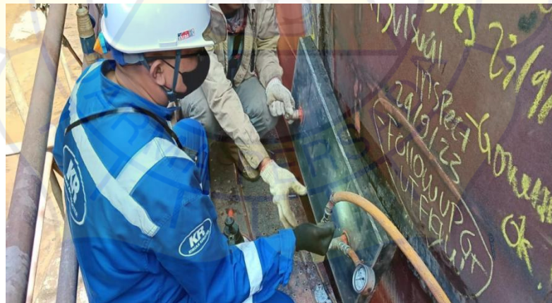
Gambar 26. Vacuum Test Sumber : Dokumentasi Milik Pribadi
