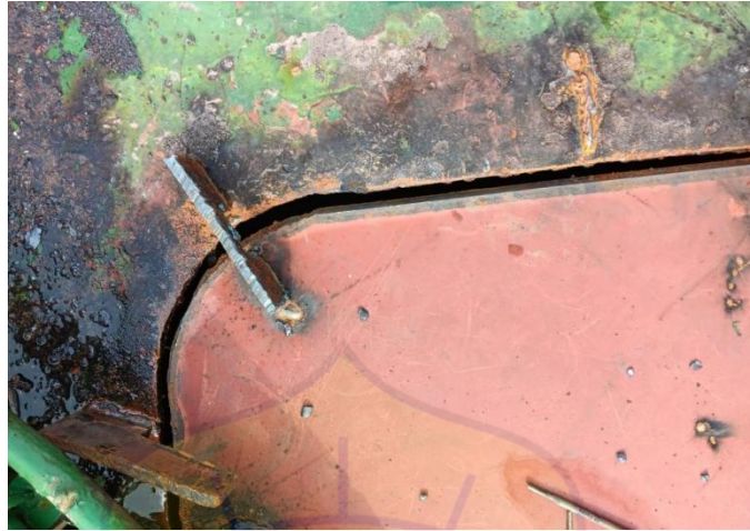
Gambar 8. Fit Up Check round pada Replating Sumber : Dokumentasi milik pribadi
