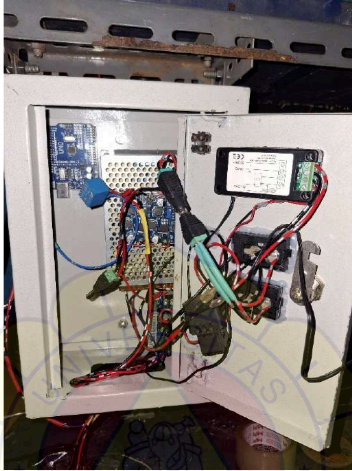
Proses Instalasi Kelistrikan
