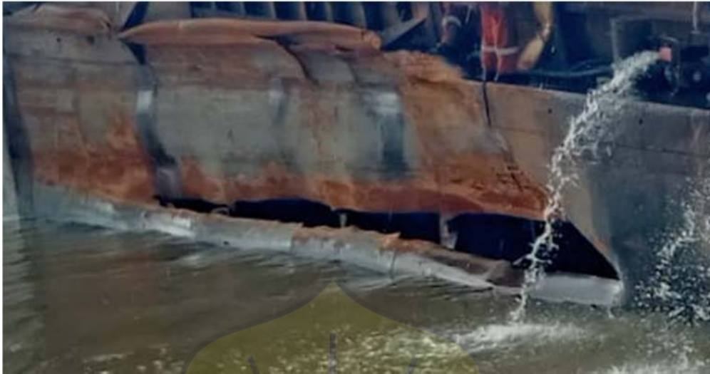
Gambar 1. 2 Kerusakan Akibat Tubrukan Tb. Iris
